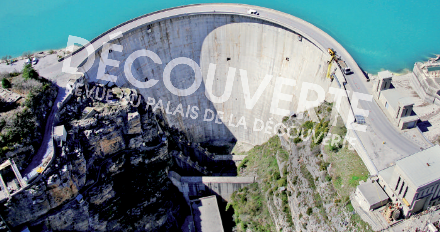
Figure 1. Parement aval du barrage de Castillon avec l'ombre incurvée de la corniche. © EDF / G. Allain.
