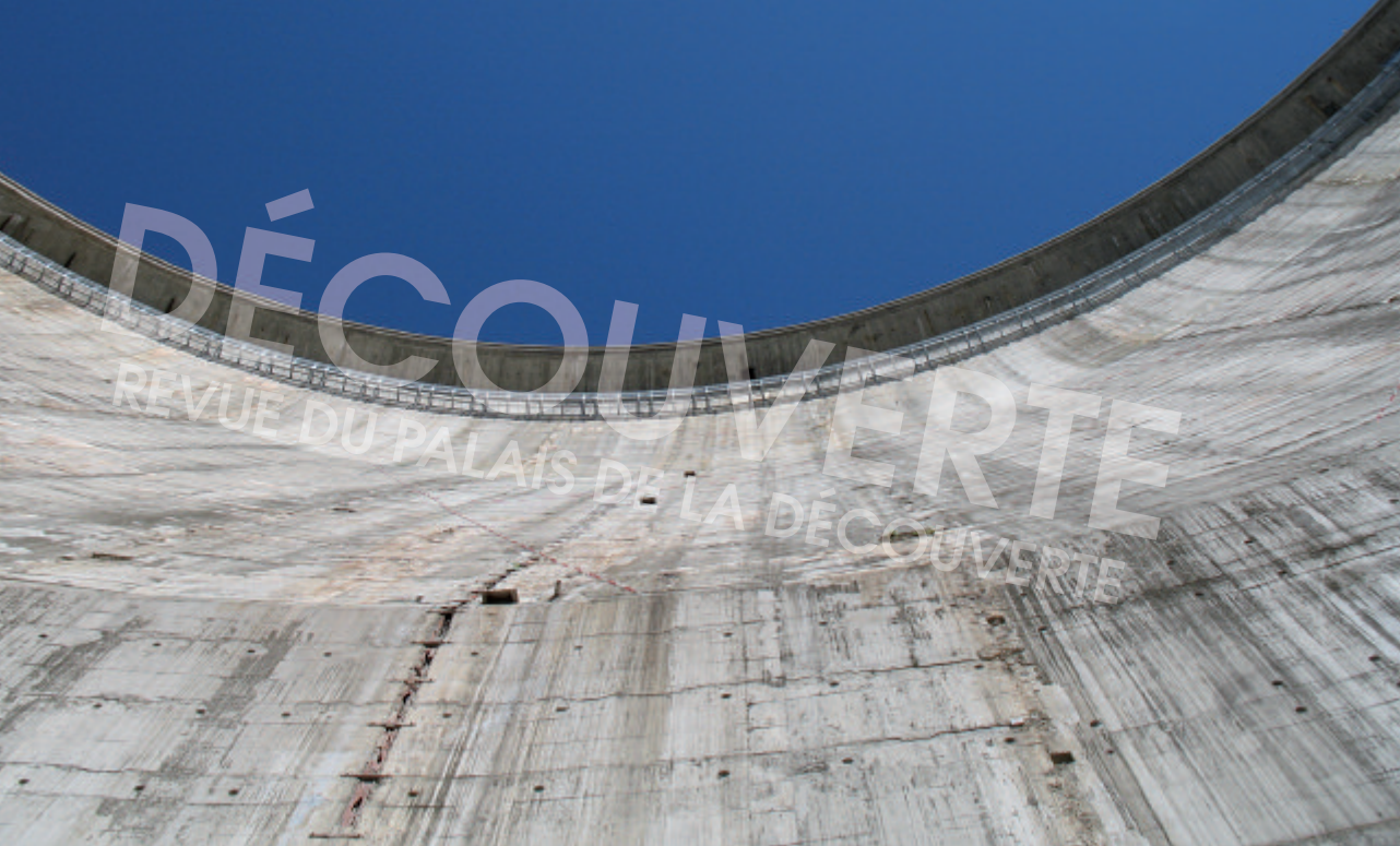
Figure 3. Photographie prise depuis le pied du barrage. Au premier plan on voit la partie cylindrique, immédiatement suivie de la portion en « limaçon de Pascal ». Plus haut, on distingue la frontière à partir de laquelle la forme devient parabolique. © D. Scavoie.
