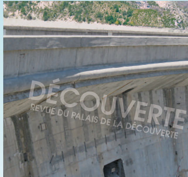
Figure 11. On voit ici l'ombre du parapet se projeter sur le bourrelet à gauche tandis qu'au milieu il commence à être éclairé. Cela signifie que sur la voûte du barrage, une partie de l'ombre est due au parapet, l'autre au bourrelet. © D. Savoie.
